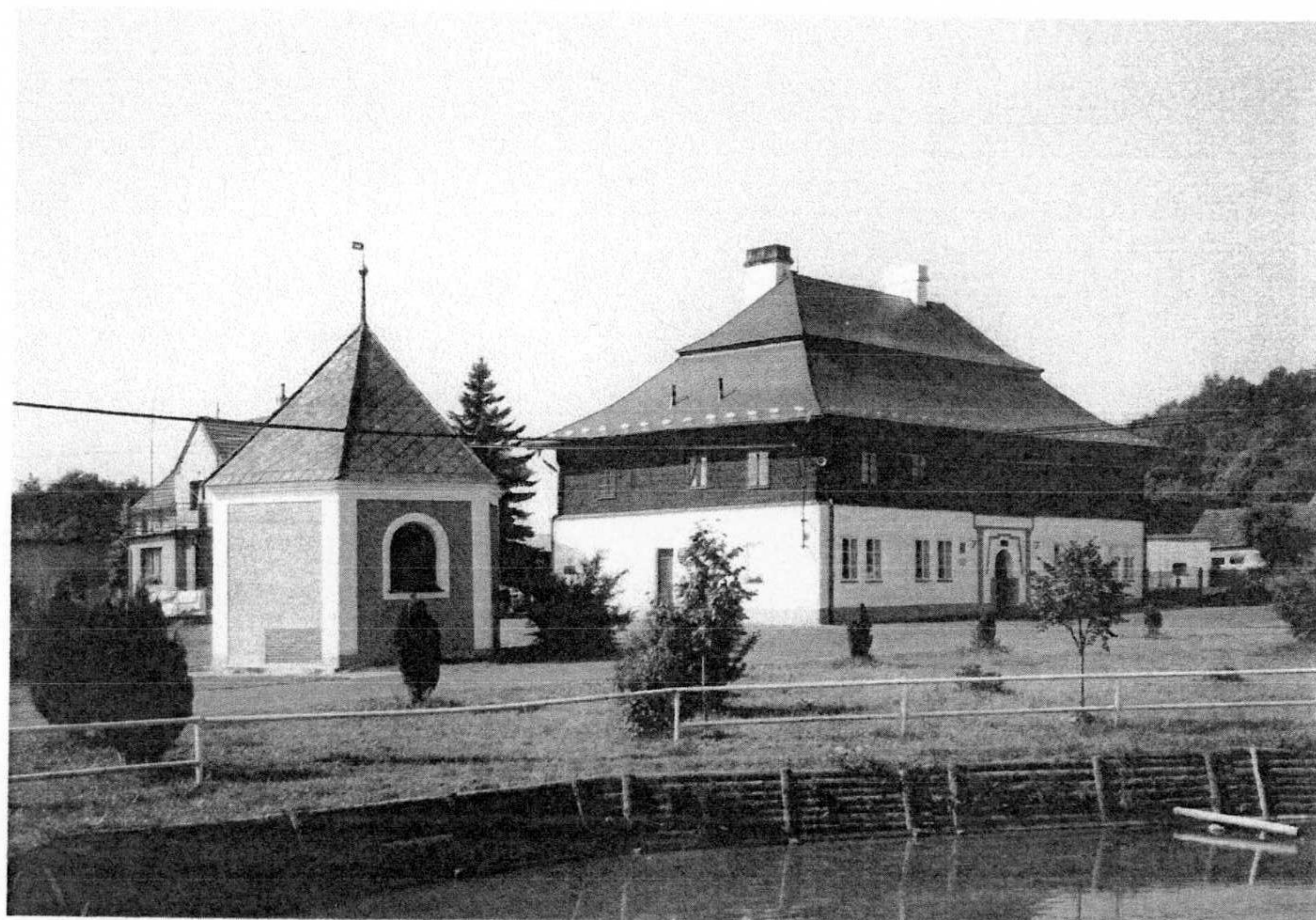
Obr. č. 5: Pramen Vojtěška s kaplí v Milavčích, kaple a bývalý lázeňský dům, 2000. Foto L. Krčmář.
